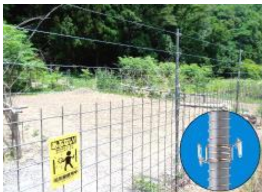
イノシシ・サル複合防護柵 (鉄筋柵＋電気柵)
